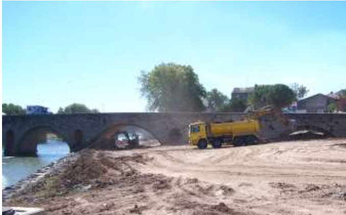
En haut : Travaux de dégagement des arches du Pont Béziers
