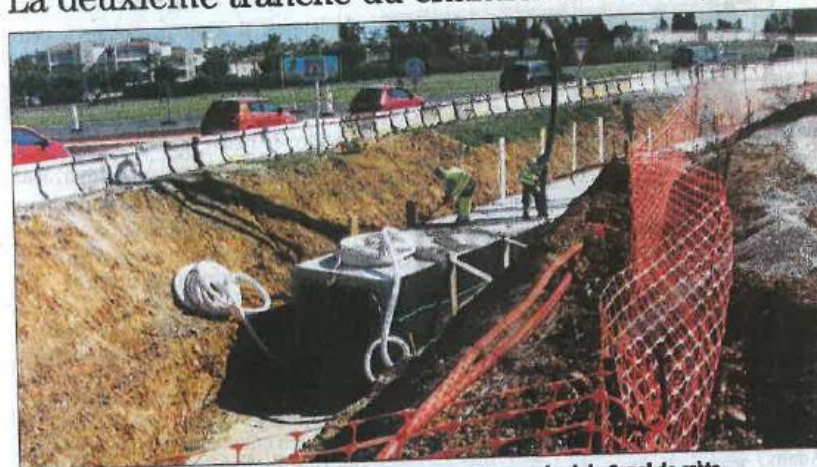
■ Des travaux qui permettront un meilleur écoulement des eaux de pluie Canal de crête.
