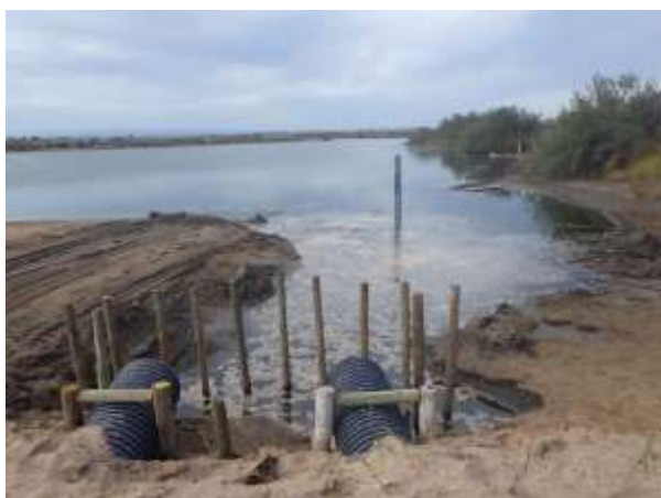
Pose de pieux devant les prises d'eau pour bloquer les bois flottants
