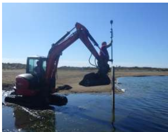
Calage de l'échelle limnimétrique (Lagune la Rivièrette)
