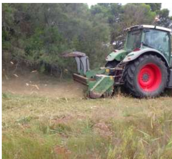
Les travaux d'entretien de la végétation des fossés et canaux produisent de grandes quantités de bois. Pour éviter la remobilisation des rémanents de coupe lors des inondations, ils ont été soigneusement broyés sur place
