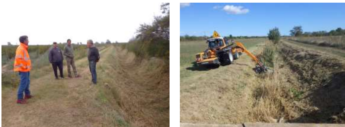
Visites des chantiers en cours avec les explications de M. Lamy, conducteur des travaux chez ARF
