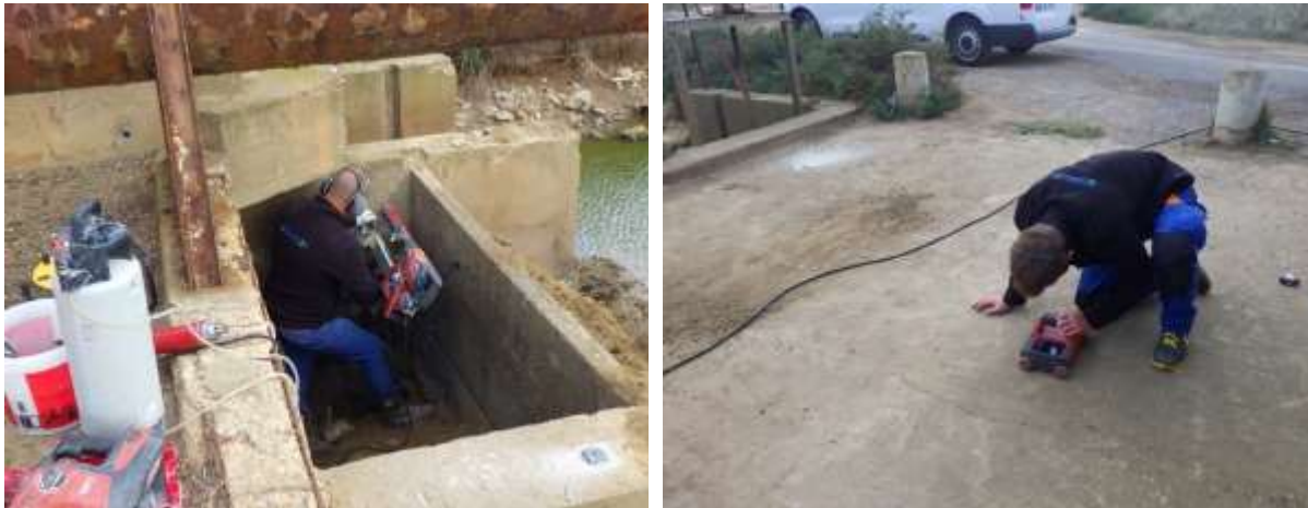
Carottage des différentes parties du bâtiment et osculation des armatures
