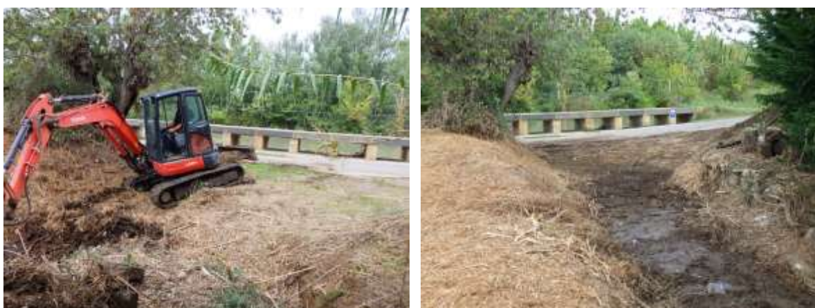
Débroussaillage de la végétation, collecte des déchets et curage des limons au départ du ruisseau l'Emeraude, au droit de l'épanchoir du canal du Midi. Avant et après intervention.
