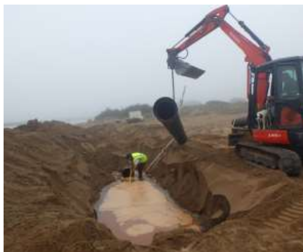
Pose de 80 mètres de tubes annelés DN 400 ancrés tous les 10 mètres. La mauvaise météo et l'élévation du niveau de la mer ont rendu difficile les opérations. Les eaux de mer s'infiltraient au travers du grau pour rejoindre la lagune la Rivièrette.
