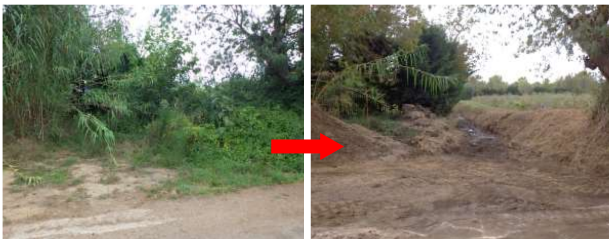
Débroussaillage de la végétation, collecte des déchets et curage des limons au départ du ruisseau l'Emeraude, au droit de l'épanchoir du canal du Midi. Avant et après intervention.
