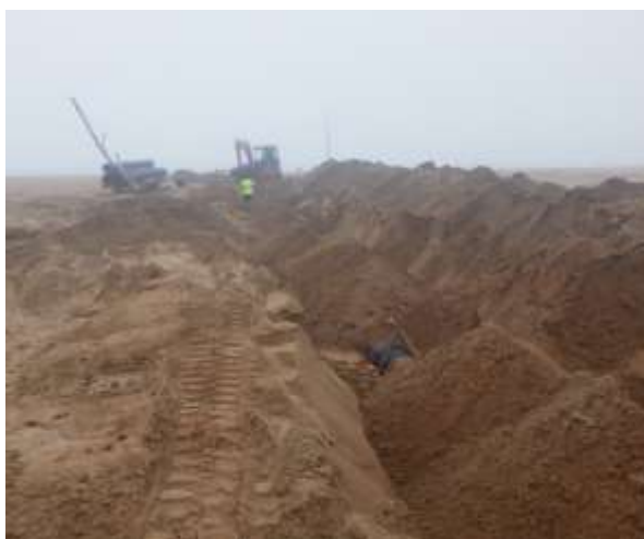
Pose de 80 mètres de tubes annelés DN 400 ancrés tous les 10 mètres. La mauvaise météo et l'élévation du niveau de la mer ont rendu difficile les opérations. Les eaux de mer s'infiltraient au travers du grau pour rejoindre la lagune la Rivièrette.
