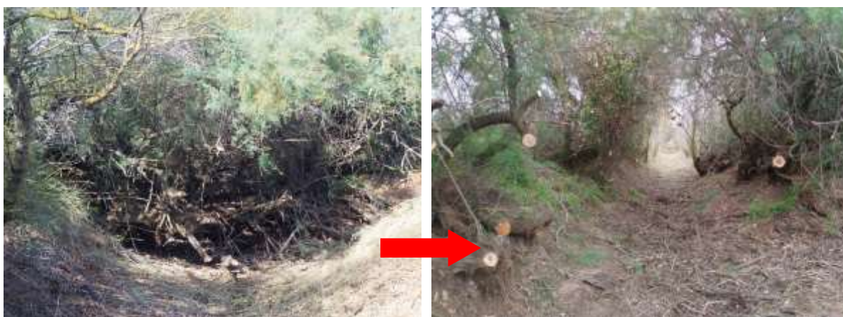
A la confluence des ruisseaux Emeraude et Cantonade. Dégagement de la section d'écoulement. Avant et après intervention.
