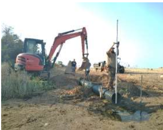
Pose des prises d'eau dans la lagune à 0.50 m Ngf et de la chambre de vannage. Les tubes annelés DN 400 sont scellés tous les 10 mètres avec des rondins de bois traités.
