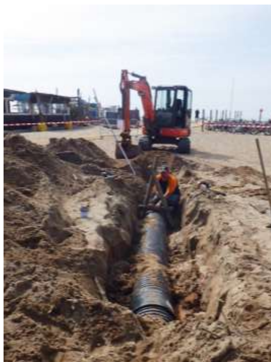
Pose des prises d'eau dans la lagune à 0.50 m Ngf et de la chambre de vannage. Les tubes annelés DN 400 sont scellés tous les 10 mètres avec des rondins de bois traités.
