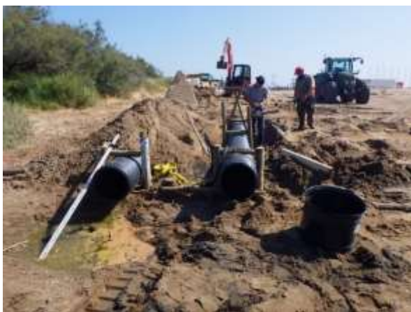
Pose des prises d'eau dans la lagune à 0.50 m Ngf et de la chambre de vannage. Les tubes annelés DN 400 sont scellés tous les 10 mètres avec des rondins de bois traités.
