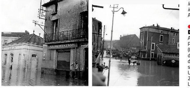
Tout le Faubourg étant sous l'eau, dans certaines voies, les barques étaient de mise pour circuler.
