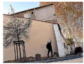
Un rempart a été installé sur le mur des anciens Ets Andoque.
