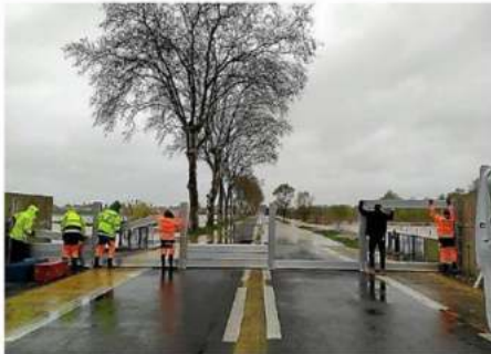
Les batardeaux ont été installés dans le prolongement de la digue et dans les points sensibles de la ville.
