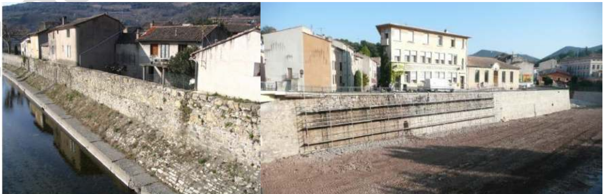
A droite, le rempart de Villemagne l'Argentière le long de la Mare avant travaux A gauche, la digue de la Poste à Bédarieux pendant les travaux de confortement
