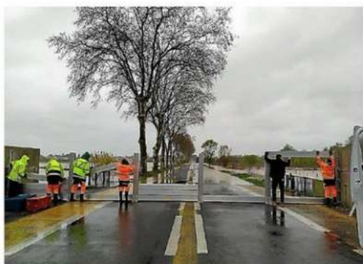
Les batardeaux ont été installés dans le prolongement de la digue et dans les points sensibles de la ville.
