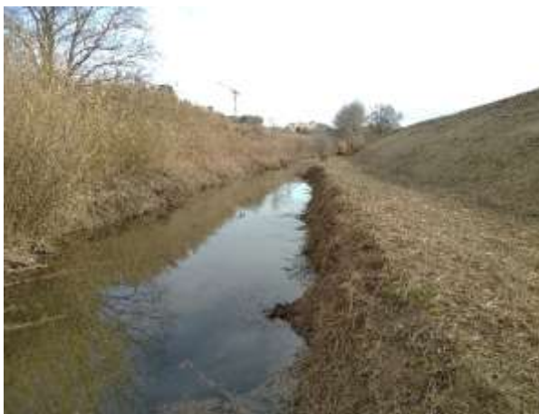
Reprofilage du pied de berge et création d'une banquette submersible, avant et après intervention
