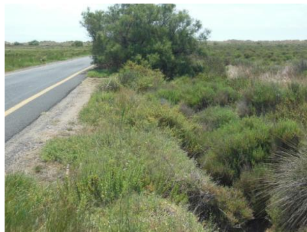
La végétation obstrue totalement les fossés
