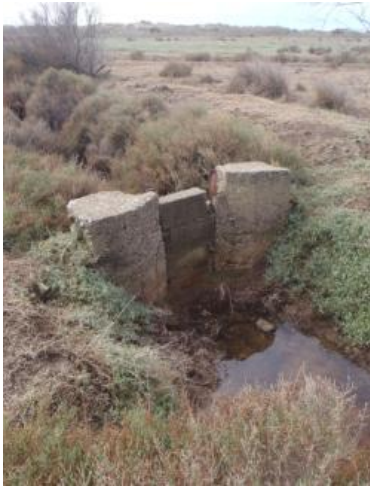
Scellement d’ouvrage hydraulique
