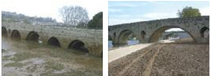
7 - Rétablissement du passage de l'Orb sous le Pont Vieux à Béziers
