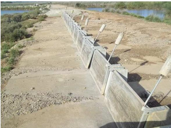
Barrage anti-sel du Pont de Cayrol (avec joint défectueux) (3)
