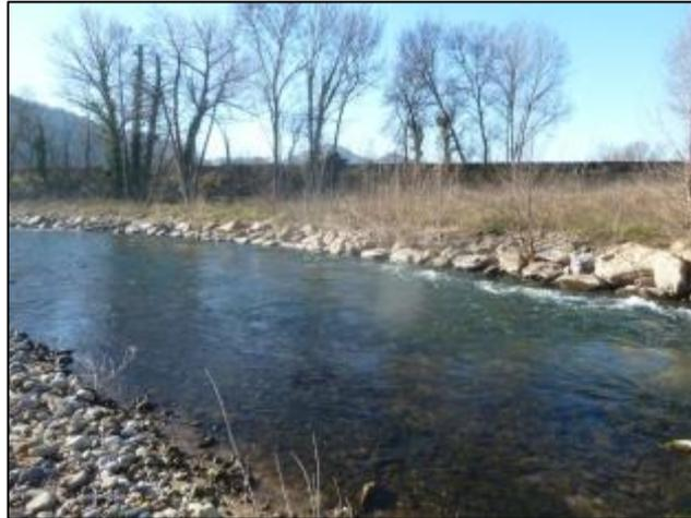
**Enrochements réalisés au pied de la digue protégeant un captage AEP**
