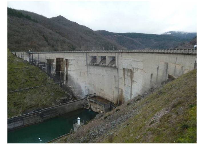
Barrage des Monts d'Orb
