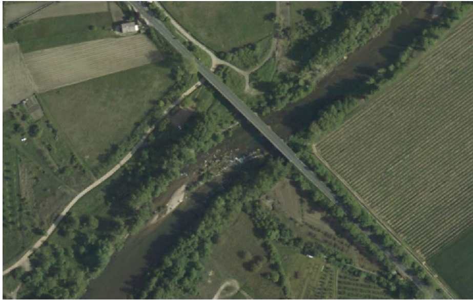
PHOTO 5 : PONT D'HÉRÉPIAN DÉBUT DES ANNÉES 2011 (ÉCOULEMENT LOCALISÉS SOUS DEUX ARCHES, RÉDUCTION DE LA BANDE ACTIVE, DÉVELOPPEMENT DE LA RIPISYLVE QUI PEUT FIXER CERTAINS BANCS).
