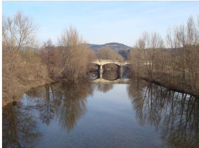
PHOTO 7 : PONT SNCF DE LA MARE 2011 (AU DROIT DE LA PHOTO UN SEUIL STABILISE LE PROFIL EN LONG, INCISION IMPORTANTE DE LA MARE SUITE AUX EXTRACTIONS AINSI QU'À LA RECONQUÊTE FORESTIÈRE SUR LES VERSANTS. SEUIL TRANSPARENT POUR LE TRANSIT SÉDIMENTAIRE).
