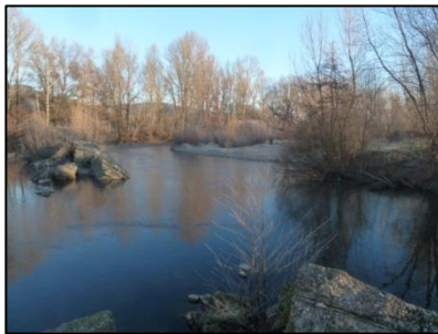
FIGURE 30 : ANCIEN SEUIL DE TRÉBOULÈNE
