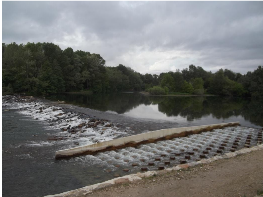
Photo 11 : Seuil de La Malhaute
