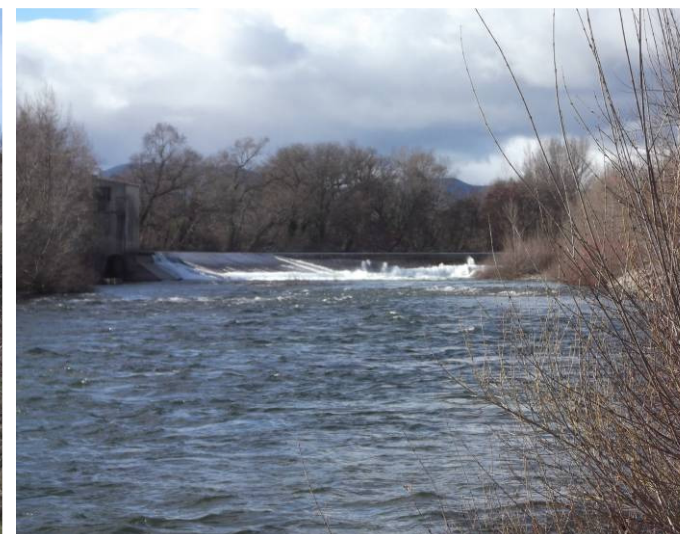
Seuil de Moulin Neuf
