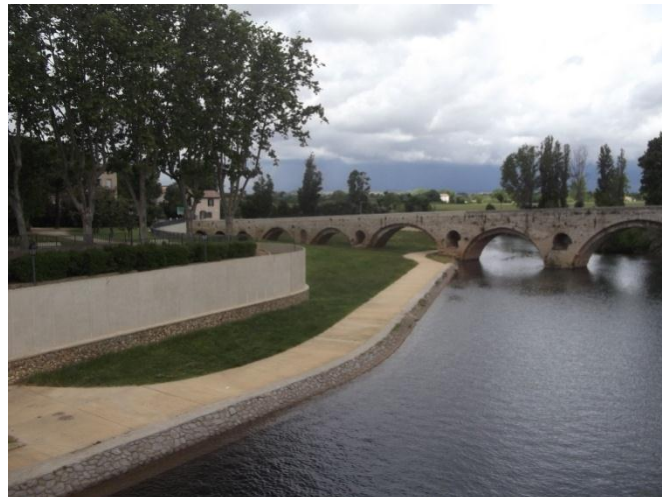
Photos 13 : L'Orb au centre Béziers, des digues de béton ont été mises en place pour limiter les débordements de la rivière , elles accélèrent les écoulements
